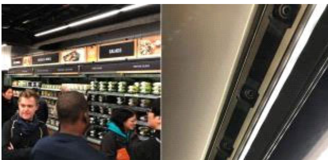
▲아마존고 매장 내부(왼쪽)와 천장에 설치된 각종 센서들
